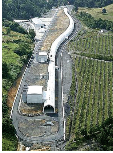
Şekil 2: San Pedro de Anes (İspanya)'de Tünel Havalandırma ve Yangın Deneyleri Merkezi'nde bulunan deney tüneli
