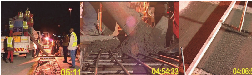
ŞEKİL 2 – BETONUN DÖKÜLMESİ, YERLEŞTİRİLMESİ VE YÜZEY BİTİRME İŞLEMLERİ
