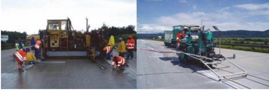
ŞEKİL 17 – ŞERİT YENİLEME: BETON VE FREZELENMİŞ KANALLARIN DÜZENLENMESİ
