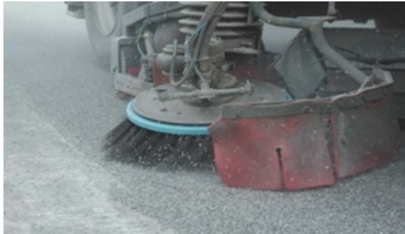
ŞEKİL 23 – FAZLA AGREGANIN SÜPÜRÜLMESİ
