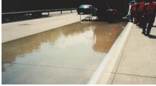
ŞEKİL 21 – MAKİNE İLE REAKTİF REÇİNE UYGULAMASI
