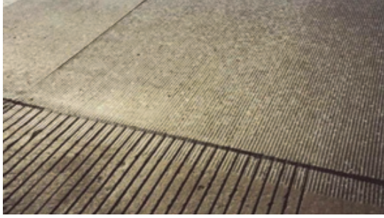
ŞEKİL 15 – KANALLI FREZELEME
