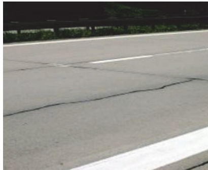
ŞEKİL 11 – GENİŞLETİLİP DOLDURULMUŞ ÇATLAK
