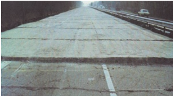
ŞEKİL 24 – BETON DÜZELTME TABAKASI
