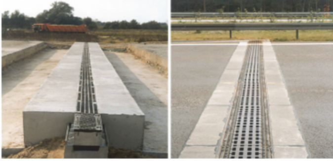
ŞEKİL 25 – KUTU KANALLARIN YERLEŞTİRİLMESİ
