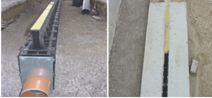
ŞEKİL 26 – TAŞMA KANALLARIN YERLEŞTİRİLMESİ
