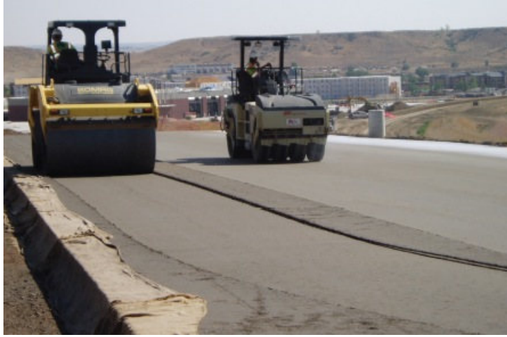
Şekil 5: SSB kaplamanın çelik ve lastik tekerlekli silindirlerle sıkıştırılması [10]
