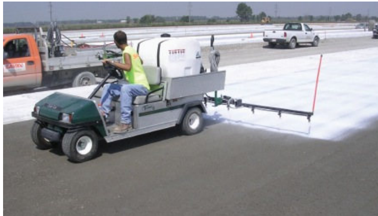
Şekil 7: SSB yolda beyaz renkli kür kimyasalı uygulanması [10]
