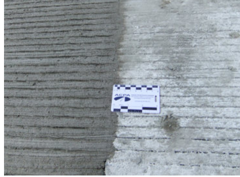
Taze betonda boyuna diş oluşturma tekniği (Illinois, ABD)
