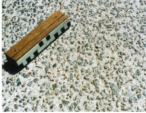
Görünür agregalı betonun yüzey dokusu 0/14(Brussels, Loraainedreef, 2003)
