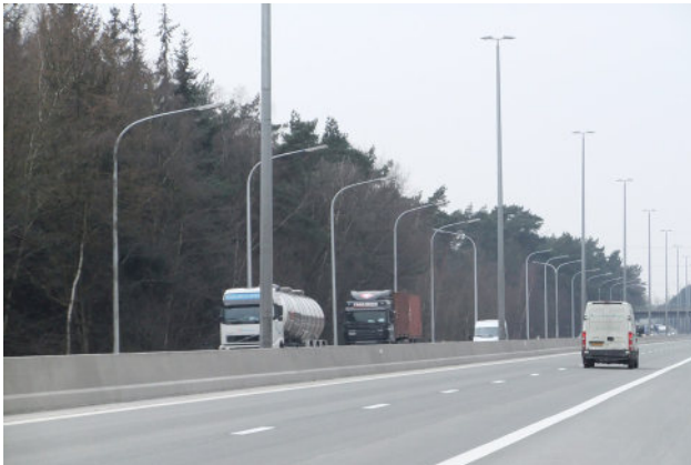
E313 Herentals-Grobbendonk: çift tabakalı görünür agregalı (üst tabakada 0/6.3) beton yüzey
