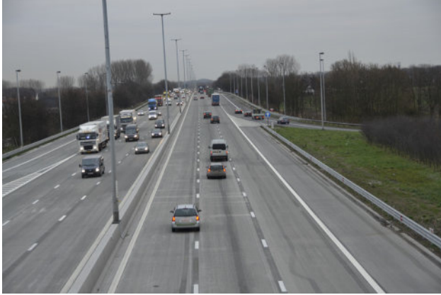
E17 De Pinte – Kruishoutem: tek tabakalı görünür agregalı beton (0/20)
