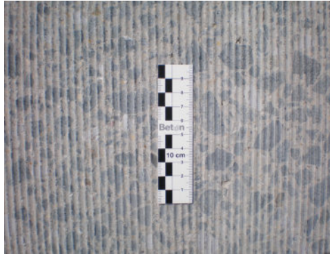
Elmas aşındırma yöntemiyle düzlenmiş yüzeyin detaylı görünümü ve Almanya’daki Geseke bağlantı yolu Fotoğraflar: S. Riffel – Ref.11
