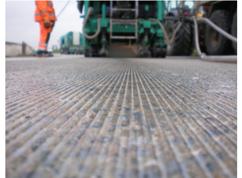
Elmas aşındırma yöntemiyle düzlenmiş yüzeyin detaylı görünümü ve Almanya’daki Geseke bağlantı yolu Fotoğraflar: S. Riffel – Ref.11
