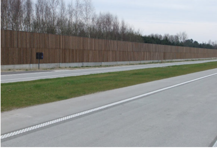
Az gürültülü çift tabakalı beton kaplama ve ses bariyerlerinin PPP projesi kapsamında N19g bağlantı yolunda birlikte kullanılması (Belçika, Geel Kasterlee)
