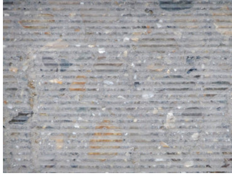
Eski beton kaplamaların restorasyonu için elmas aşındırma tekniği
