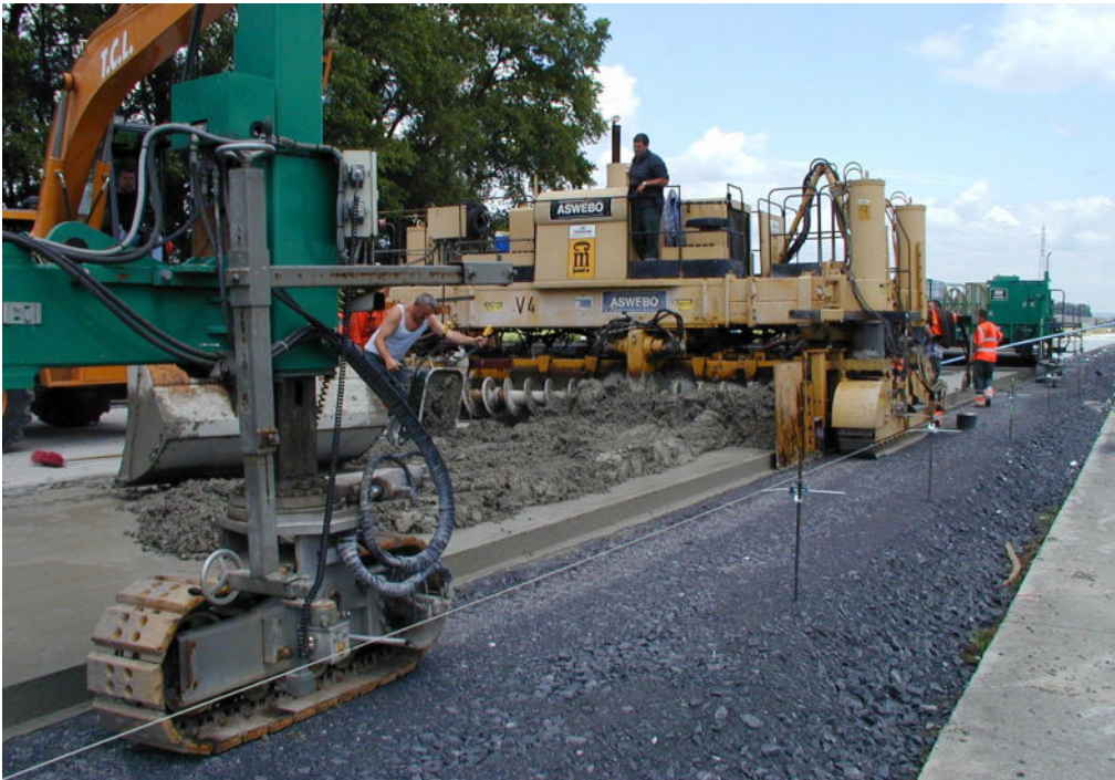
Estaimpuis: iki tabakalı sürekli donatılı beton kaplamanın yapımı
