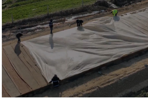
Şekil 4. Branda ile yüzey koruması
