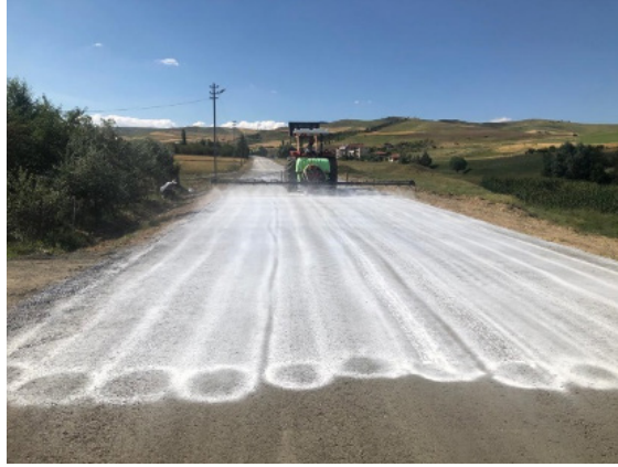
Şekil 1. Zirai ilaçlama makinesi (holder) ile kürleme
