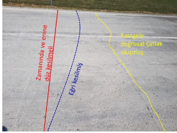
Şekil 9. Yanlış doğrultuda derz kesimi (Yaman, 2023)
