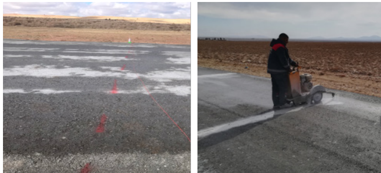
Şekil 5. Derz doğrultusunun belirlenmesi ve derz kesimi
