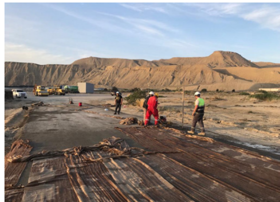
Şekil 3. Islatılmış teliz bezi ile yüzey koruması
