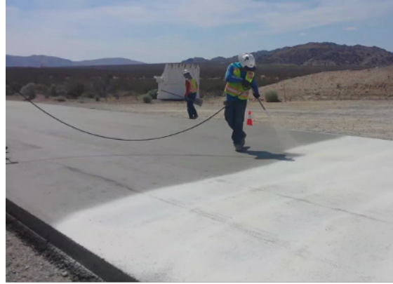
Şekil 2. Motorlu ekipmanlar ile kürleme
