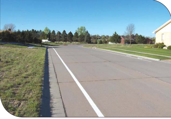
Alliance, NB'de inşa edilmiş SSB cadde inşaattan 11 yıl sonra yok denilecek kadar az bozulma belirtisi göstermiştir.
