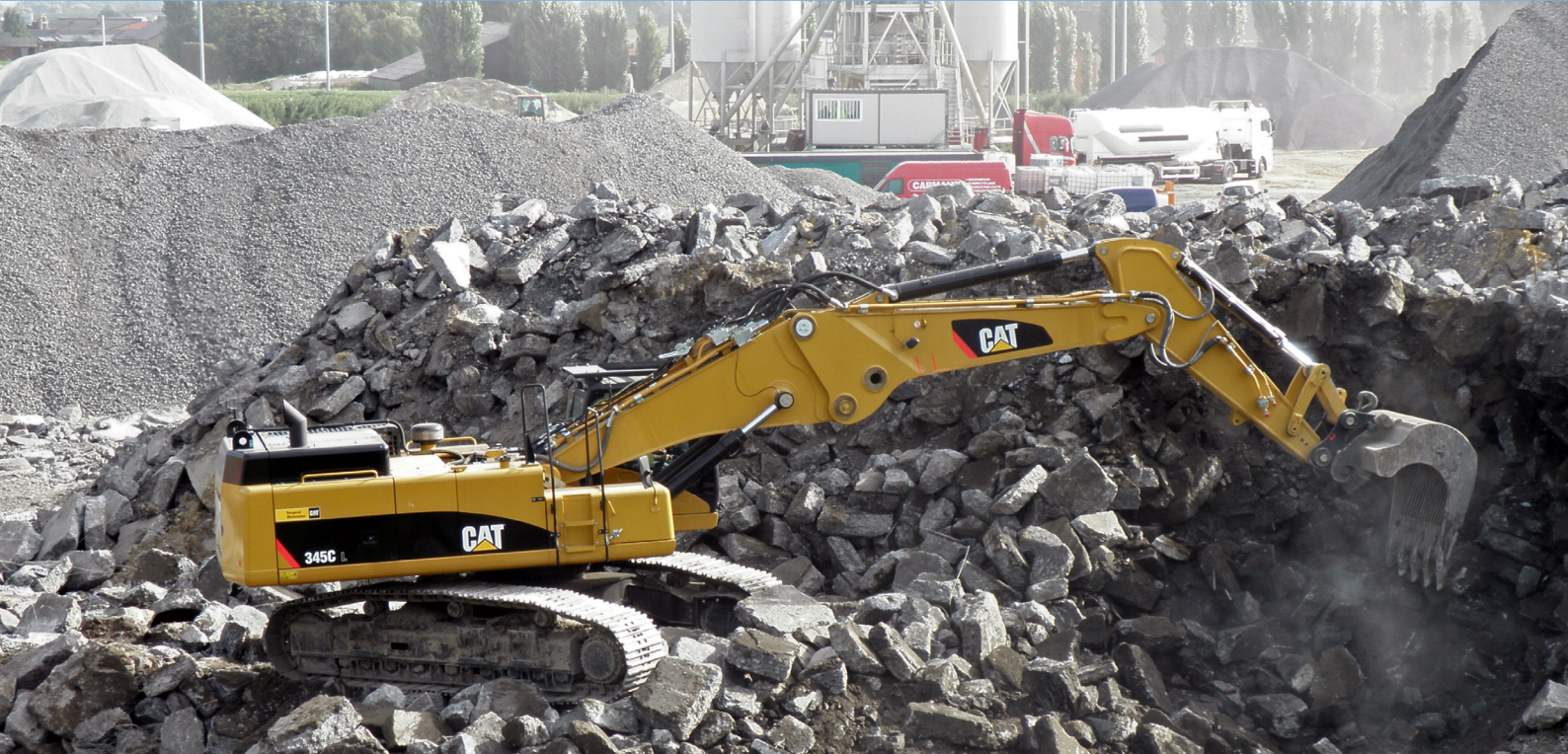
Beton yol geri dönüşümü - otoyol E17, De Pinte, Belçika, 2011 © L. Rens / FEBELCEM
