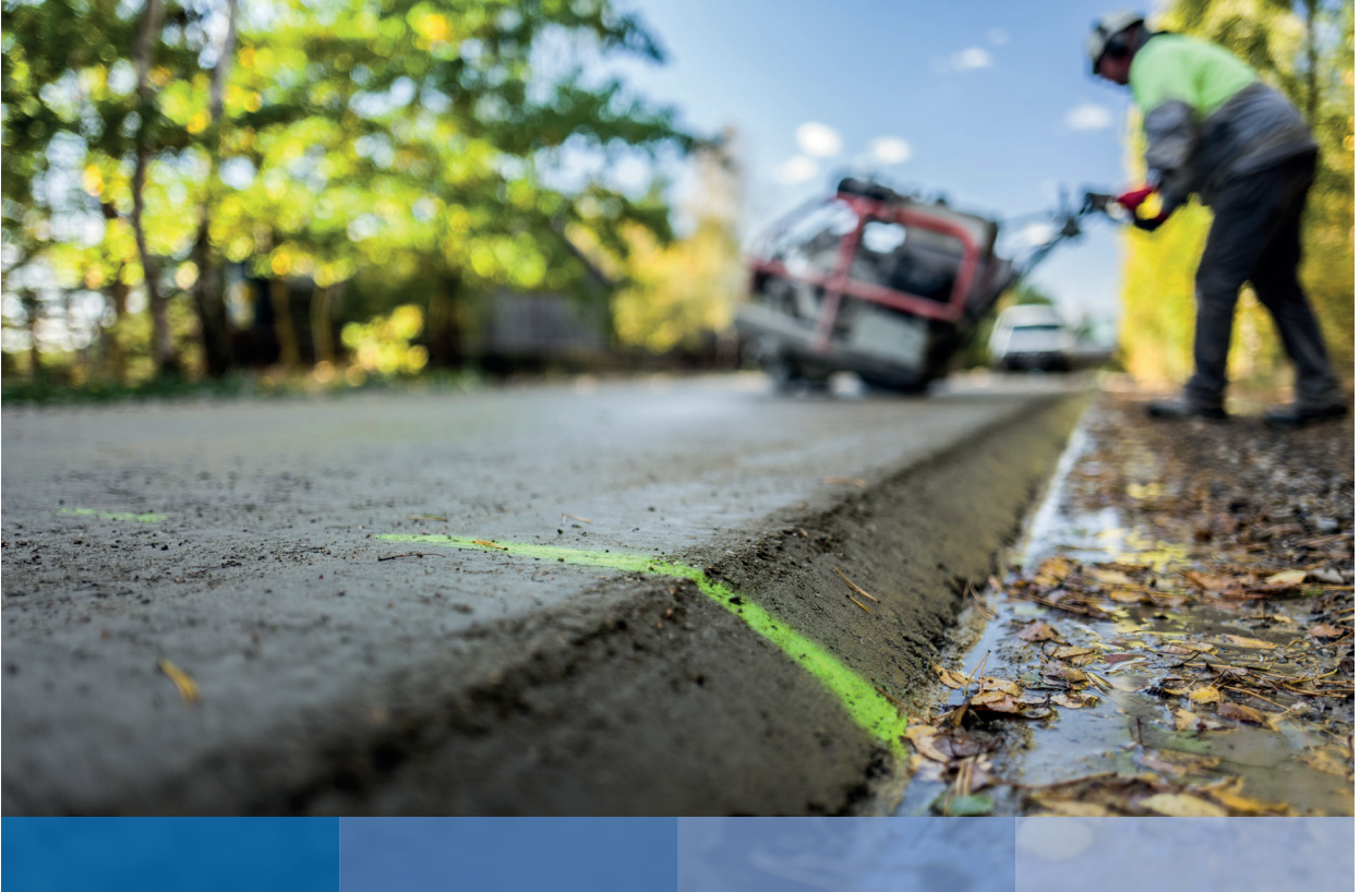
Polonya: kırsal yolu yapımı - derzlerin derz kesme makinesiyle kesimi
