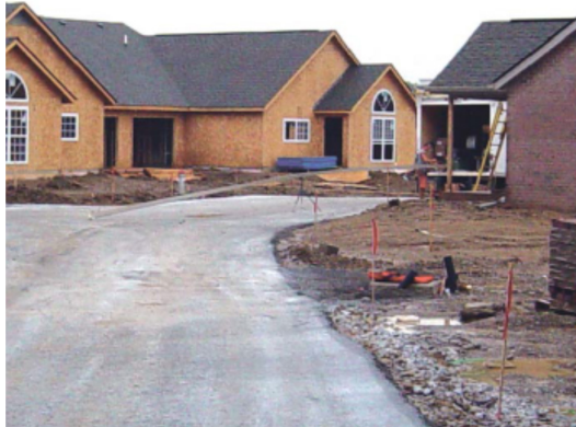
Şantiye sahası servis yolu (PCA, 2005)
