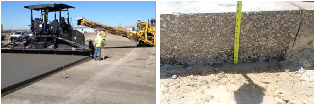
Şekil 2. Yüksek Yoğunluklu Sericilerle SSB İmalatı
