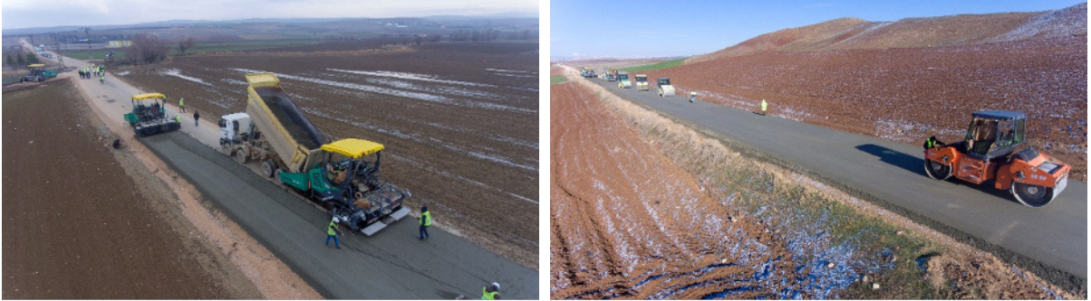
Şekil 1. SSB Serme ve Sıkıştırma İşlemleri
