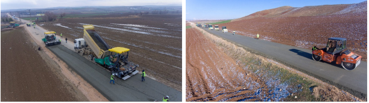
Şekil 1. SSB Serme ve Sıkıştırma İşlemleri
