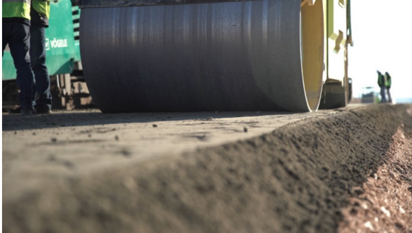
Şekil 8. SSB Yol Sıkıştırma İşlemi
