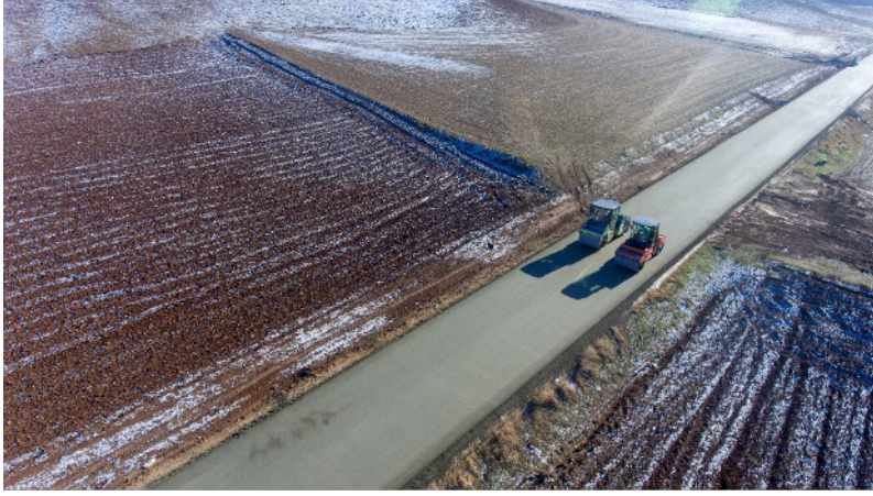
Şekil 6. SSB Yol Sıkıştırma İşlemi
