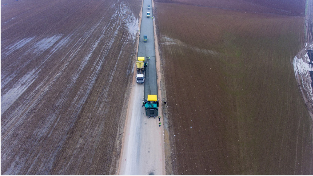
Şekil 5. Çift Serici Kullanılarak SSB Serimi
