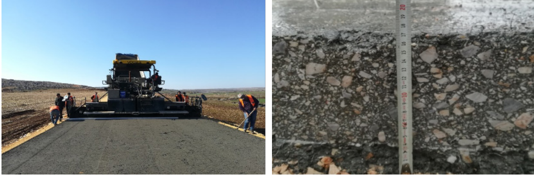
Şekil 3. Geleneksel Sericilerle SSB İmalatı
