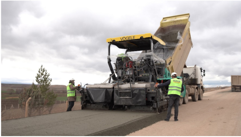
Şekil 1. SSB Yol İmalatı
