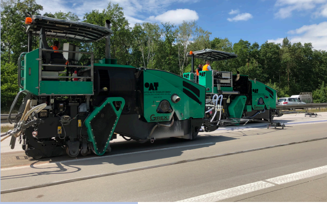
Tařlama makinesi alıřır durumda ve son derece dűřűk gűrűltűlű "Yeni Nesil Beton Yűzey"
