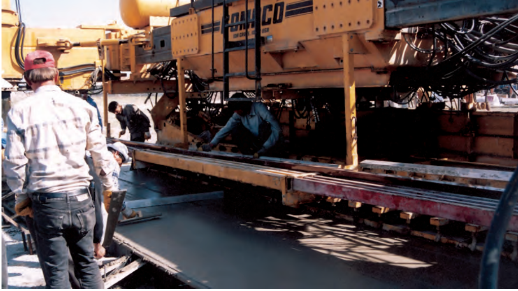
Şekil 32. Finişerin arkasından çıkan sıkıştırılmış, kalıplanmış beton
