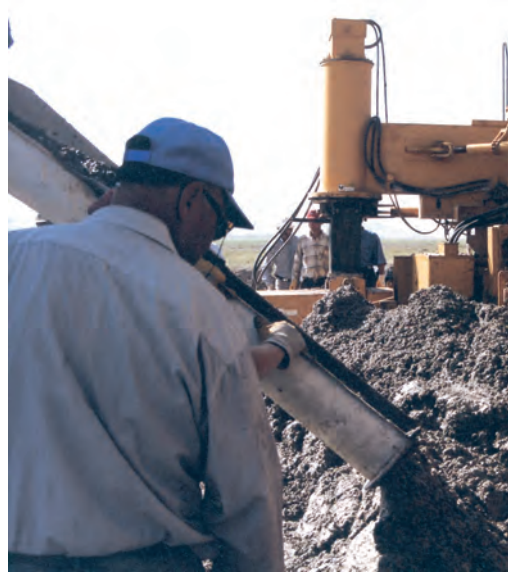
Şekil 27. Beton finişerin önüne boşaltılıyor
