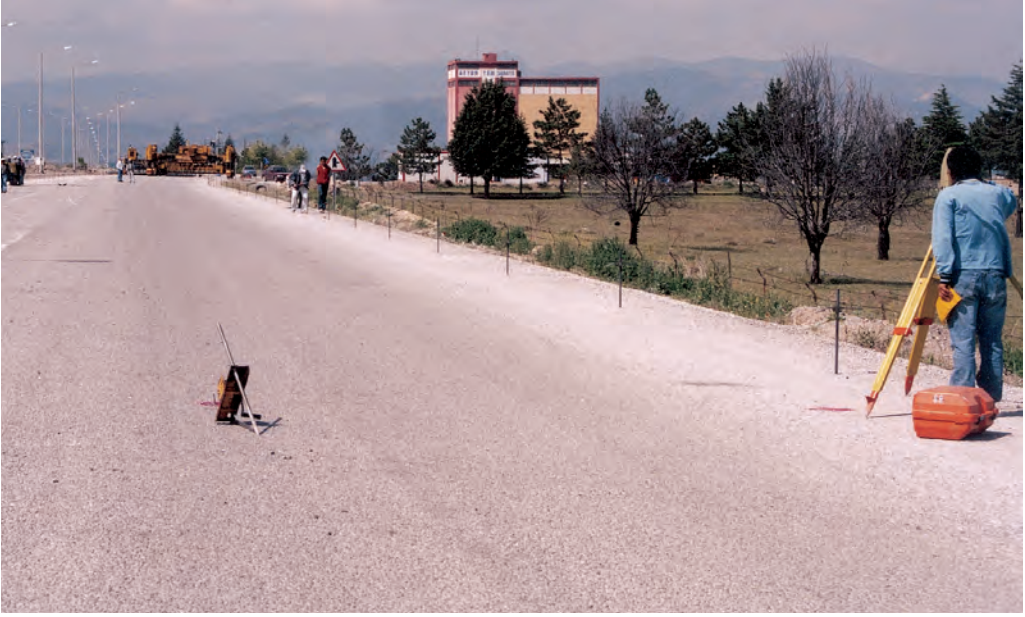
Şekil 21. Kılavuz teli geriliyor
