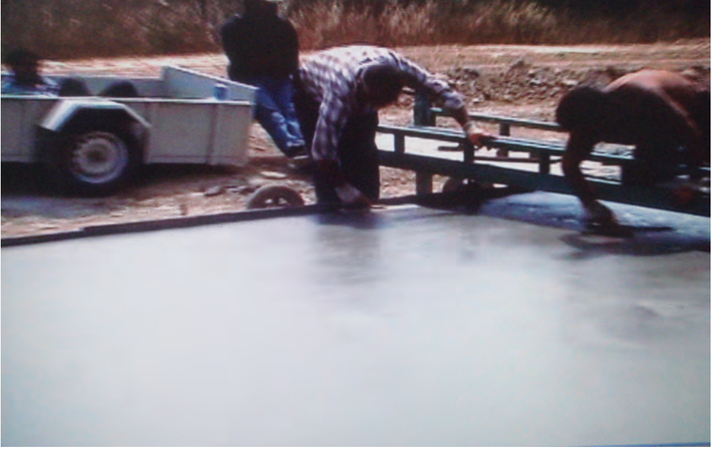
Şekil 68 Kalıplanan beton yüzeyinin düzlenmesi
