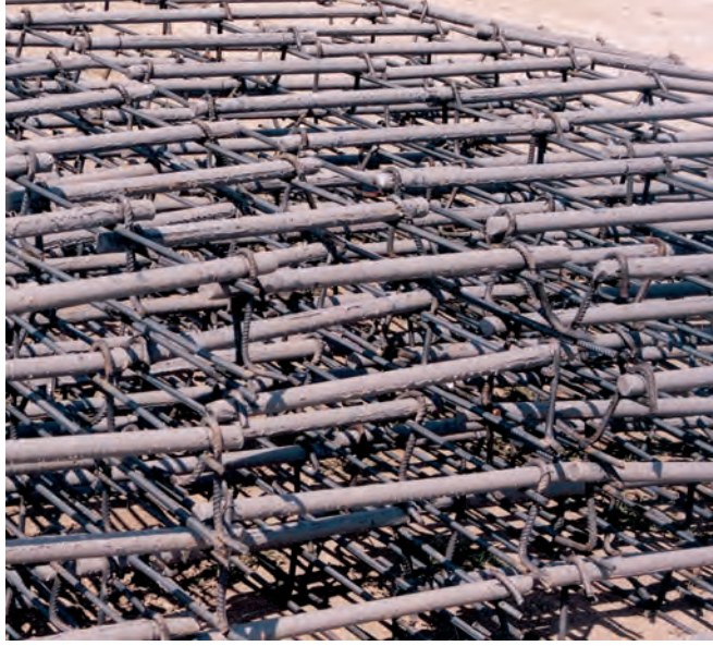
Şekil 14. Sehpalara monte edilmiş kayma demirleri
