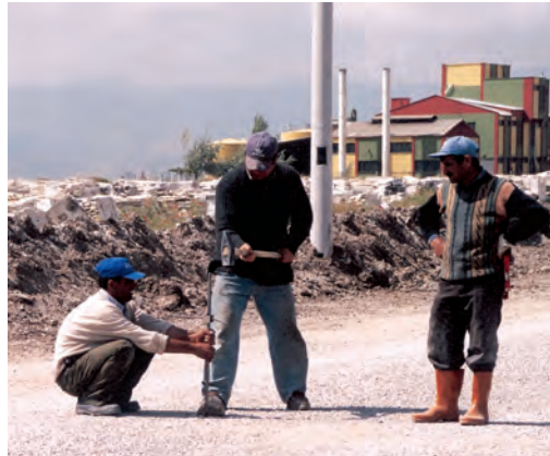
Şekil 20. Kılavuz çubukları çakılıyor
