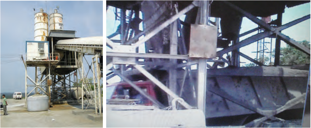
Şekil 60 Beton santrali ve kamyonu yükleme
