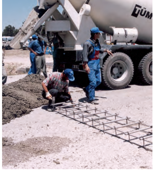
Şekil 29. Kayma demiri sehpaları enine derz hizalarına çakılıyor
