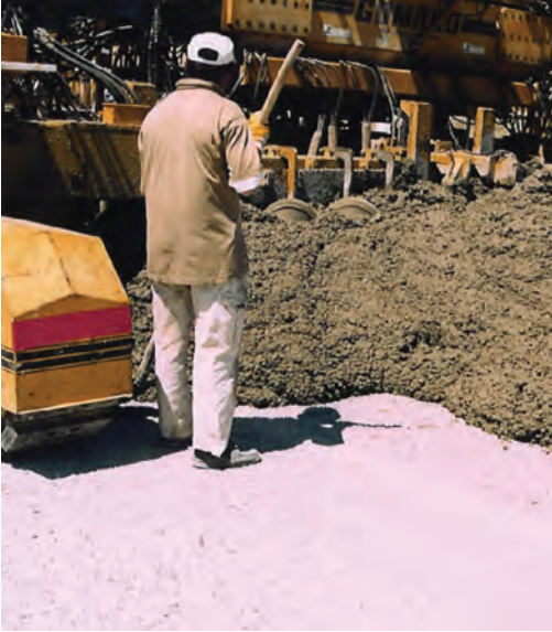
Şekil 30. Beton kayma demiri sehpalarının üstüne dökülüyor
