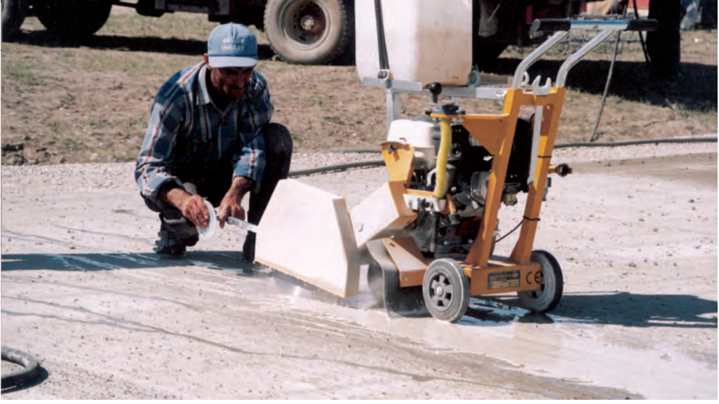
Şekil 38. Enine derz kesimi
