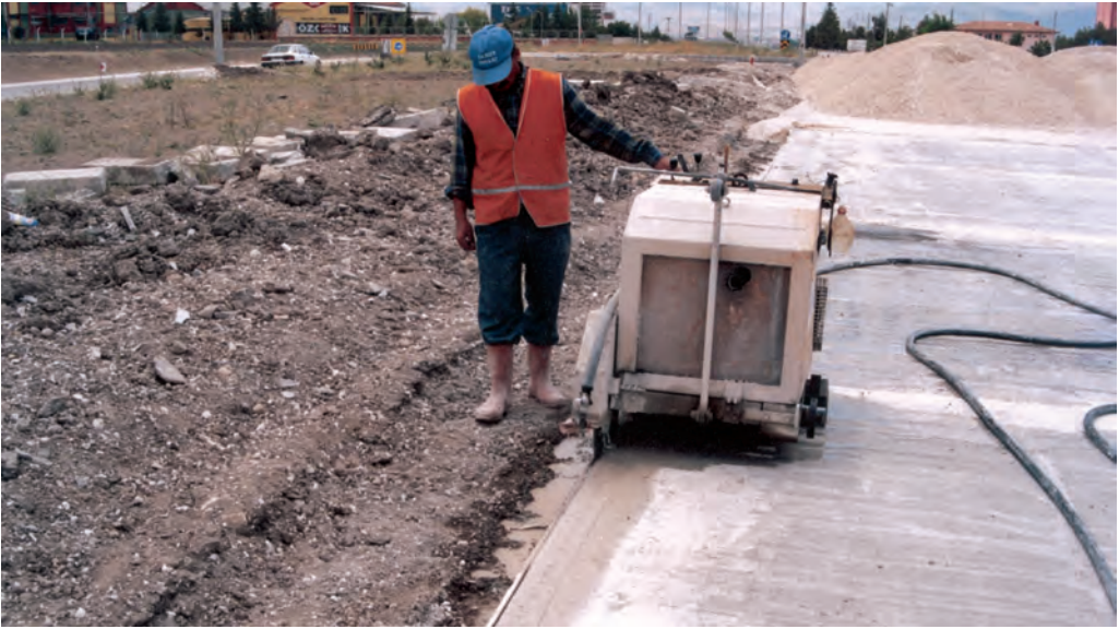
Şekil 47. Refüj bordürü için beton plak kenarı kesilip düzleniyor
