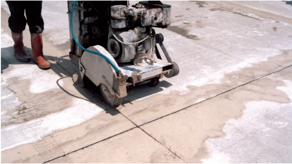
Şekil 41. Derzlerde pah açılması
