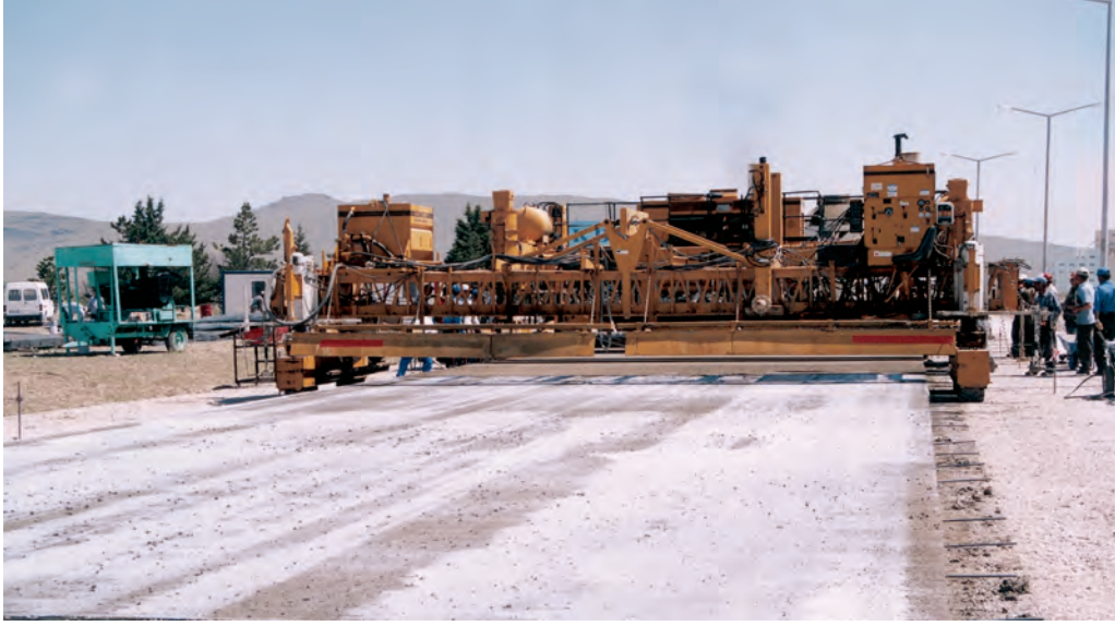
Şekil 36. Beton plak kenarındaki bağlantı demirleri
