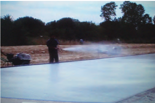
Şekil 69 Beton yüzeyine kür kimyasalı püskürtülüyor
