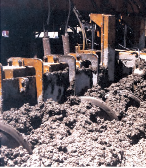
Şekil 28. Helezon şaft betonu karıştırıp yayıyor
