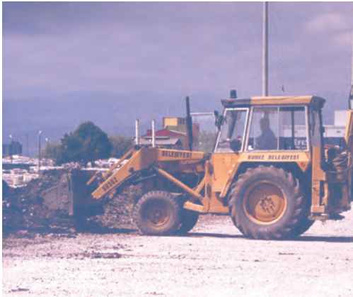
Şekil 19. Orta refüj bordürleri sökülüyor
