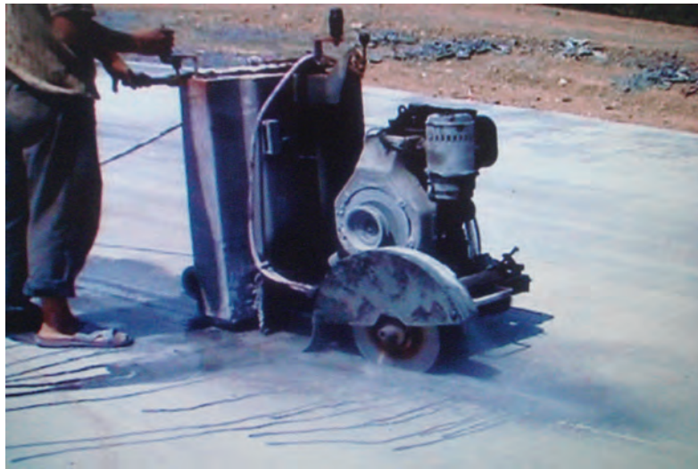
Şekil 71 Derz kesilmesi
