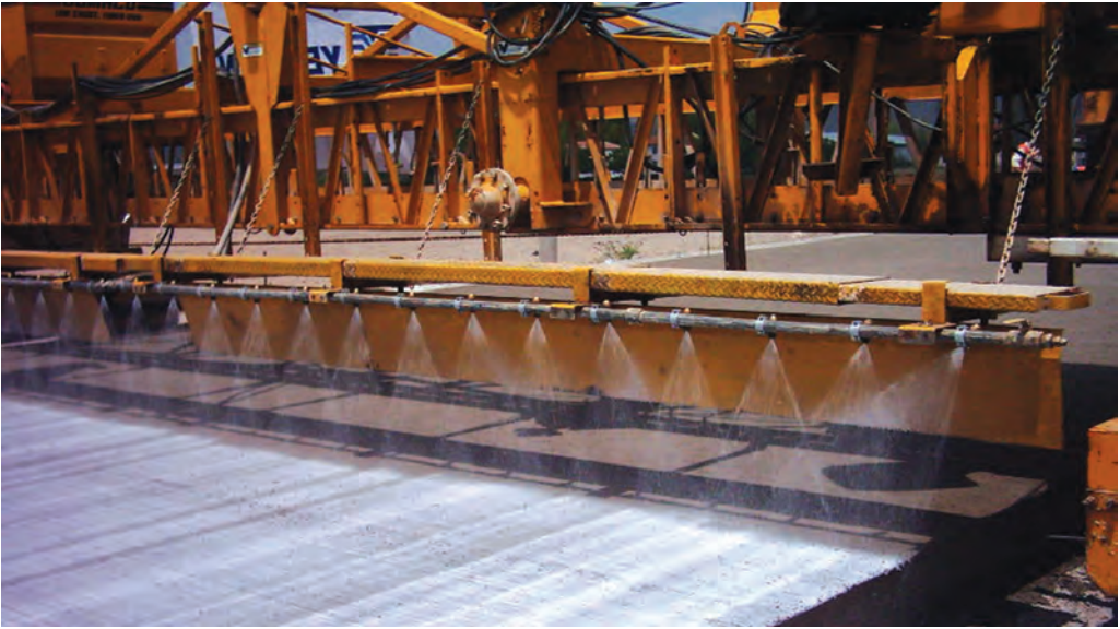
Şekil 35. Beton yüzeyine kür kimyasalı püskürtülüyor
