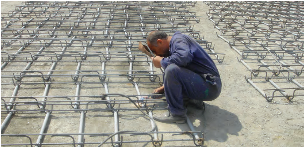
Şekil 57 Kayma demirleri sehpalara yerleştiriliyor.
