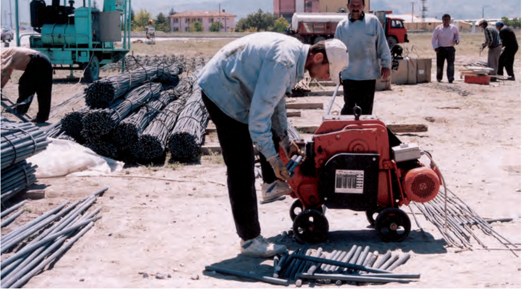
Şekil 11. Kayma demirlerinin kesilmesi ( L= 60 cm)
