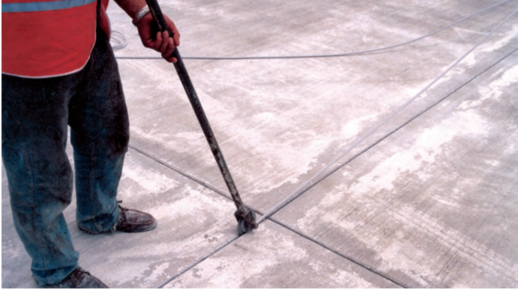
Şekil 44. Fitil derz içine bastırılarak yerleştiriliyor
