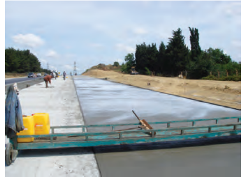
Şekil 69 Beton yüzeyine kür kimyasalı püskürtülüyor
