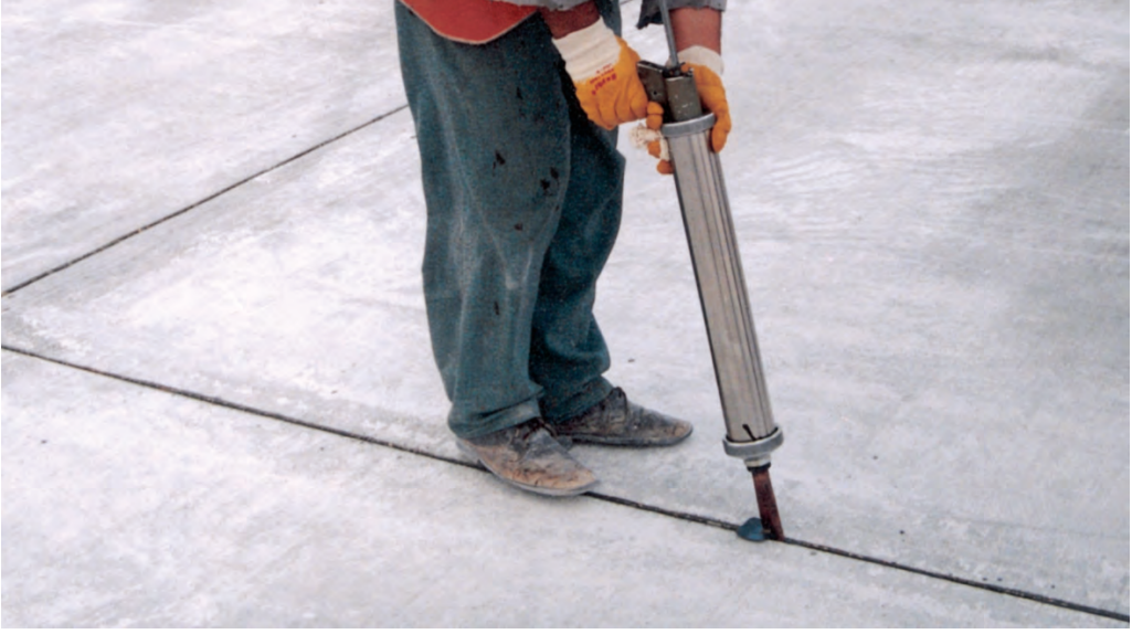
Şekil 46. Dolgu maddesi derz içine sıkılıyor
