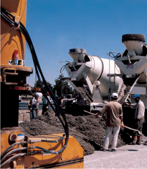
Şekil 26. Beton finişerin önüne boşaltılıyor
