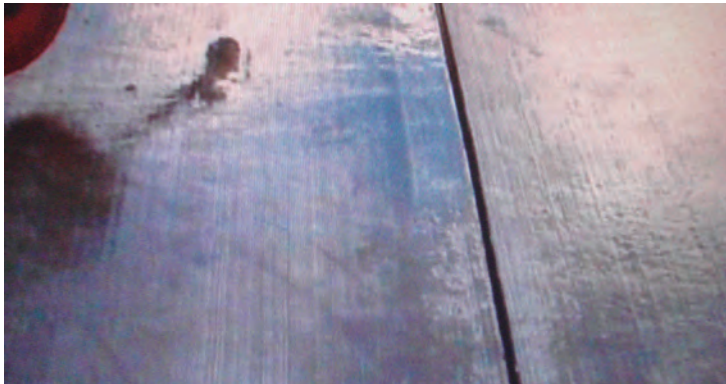
Şekil 73 Pah açılması, derz genişletilmesi
