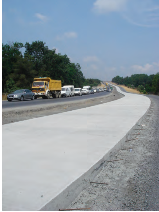
Şekil 70 Bağlantı demirleri ilk şerit kenarına yerleştirilmiş
