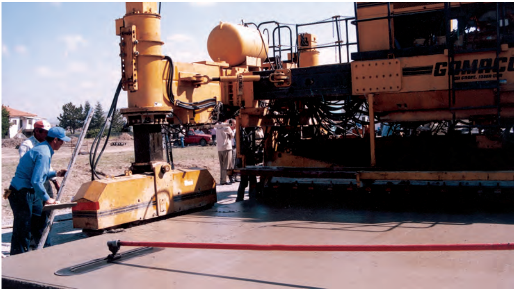
Şekil 33. Beton yüzeyi çelik master ile düzleniyor
