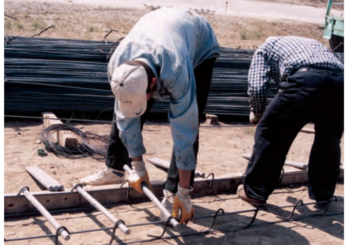
Şekil 13. Kayma demirlerinin sehpa üzerine yerleştirilmesi (@ 30 cm)
