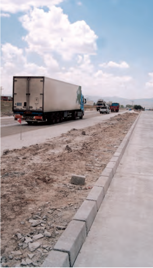
Şekil 48. Refüj bordür taşları yerleştiriliyor
