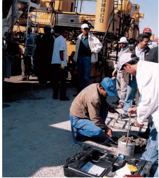
Şekil 31. Gelen betonda hava miktarı ölçümü
