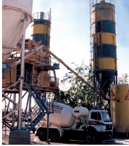
Şekil 25. Beton santralinde transmikser dolduruluyor
