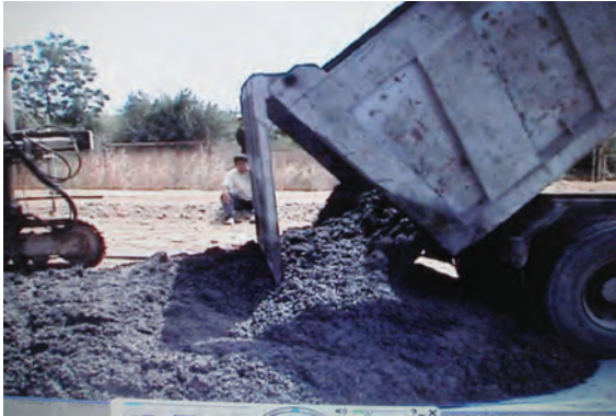
Şekil 62 Beton finişerin önüne boşaltıyor
