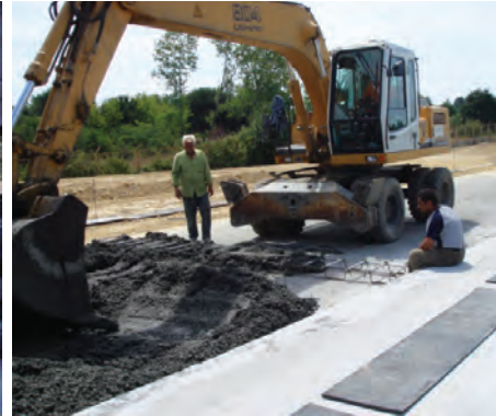
Şekil 63 Beton kepçe ile yayılıyor
