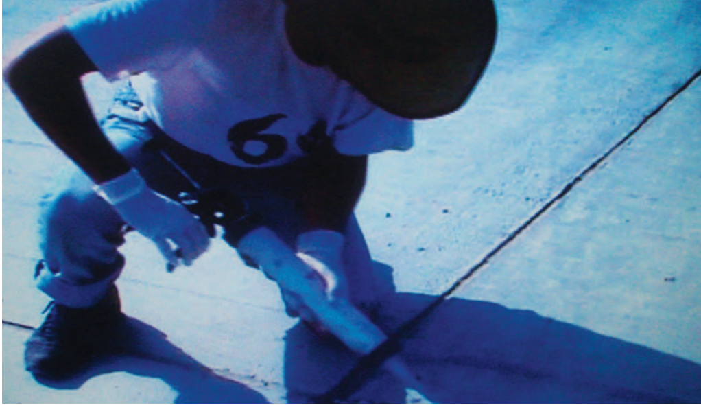
Şekil 74 Derzlerin doldurulması
