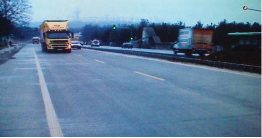
Şekil 76 Beton yol hizmete giriyor
