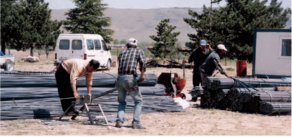
Şekil 16 Bağlantı demirlerinin kesilmesi (L=80 cm)
