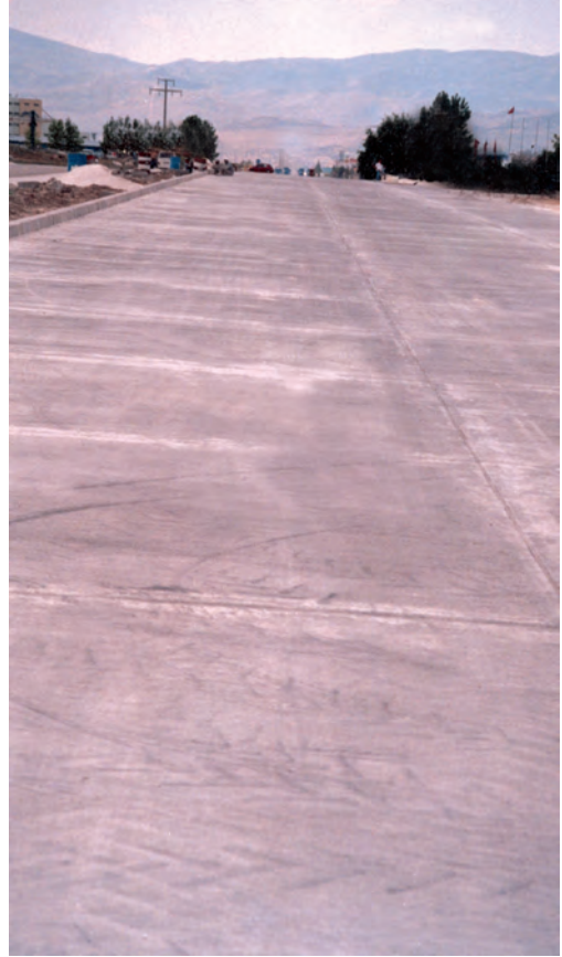
Şekil 51. Beton yol yapımı tamamlandıktan sonra
