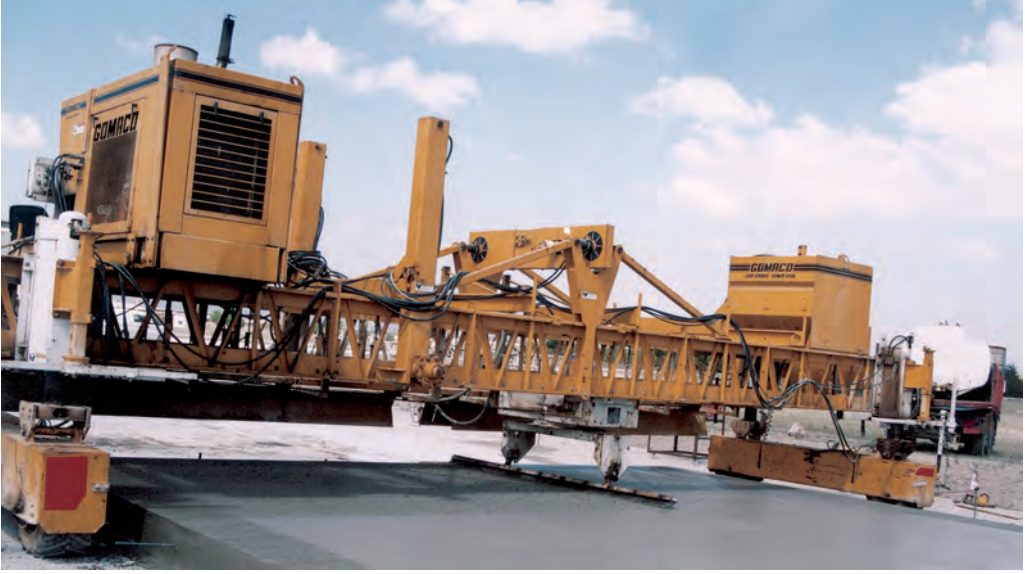
Şekil 34. Beton yüzeyi fırça ile pürüzlendiriliyor
