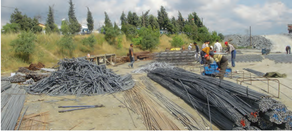
Şekil 56 Derzler için demirler hazırlanıyor
