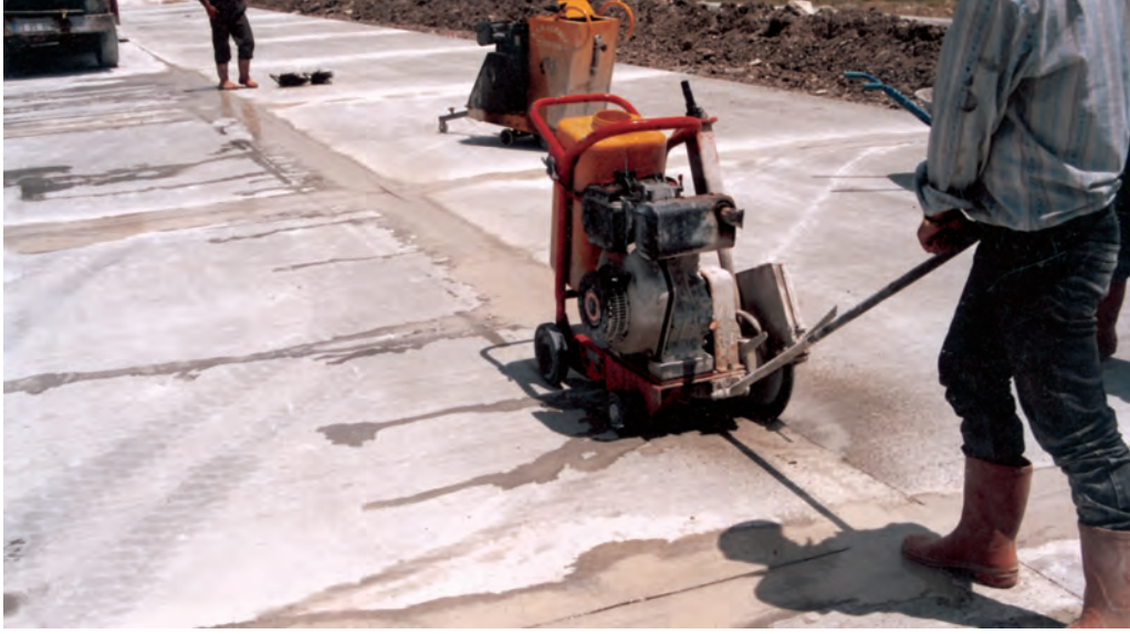
Şekil 40. Derz kalınlıkları genişletiliyor
