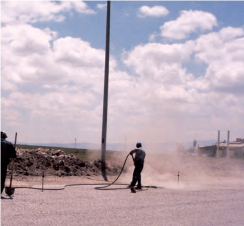
Şekil 22. Yol yüzeyi basınçlı hava ile temizleniyor
