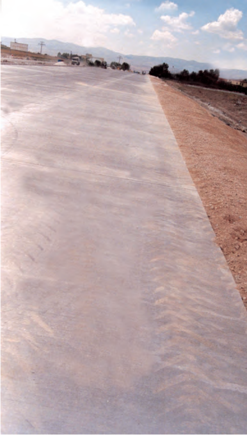
Şekil 50. Banket doldurulduktan sonra
