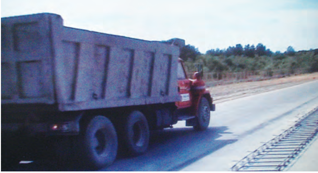
Şekil 61 Beton damperli kamyonla taşınıyor
