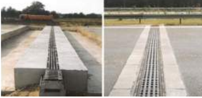
ŞEKİL 25 – KUTU KANALLARIN YERLEŞTİRİLMESİ
