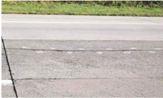
ŞEKİL 32 – RETROSPEKTİF ÇAPRAZ ANKRAJ
