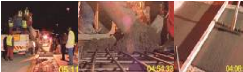
ŞEKİL 2 – BETONUN DÖKÜLMESİ, YERLEŞTİRİLMESİ VE YÜZEY BİTİRME İŞLEMLERİ
