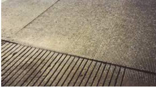
ŞEKİL 15 – KANALLI FREZELEME
