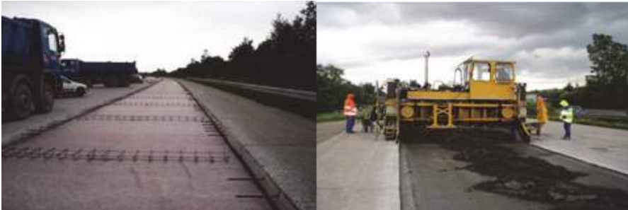
ŞEKİL 16 – ŞERİT YENİLEME: HAZIRLIK VE UYGULAMA
