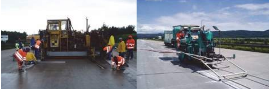
ŞEKİL 17 – ŞERİT YENİLEME: BETON VE FREZELENMİŞ KANALLARIN DÜZENLENMESİ
