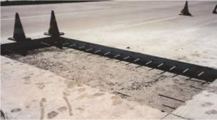
ŞEKİL 35 – PLAĞIN BİR KISMININ ANKRAJ YAPILARAK YENİLENMESİ
