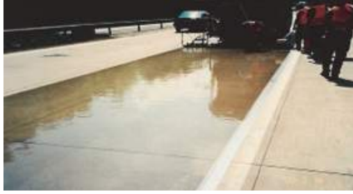
ŞEKİL 21 – MAKİNE İLE REAKTİF REÇİNE UYGULAMASI
