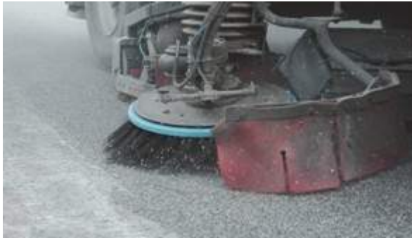
ŞEKİL 23 – FAZLA AGREGANIN SÜPÜRÜLMESİ
