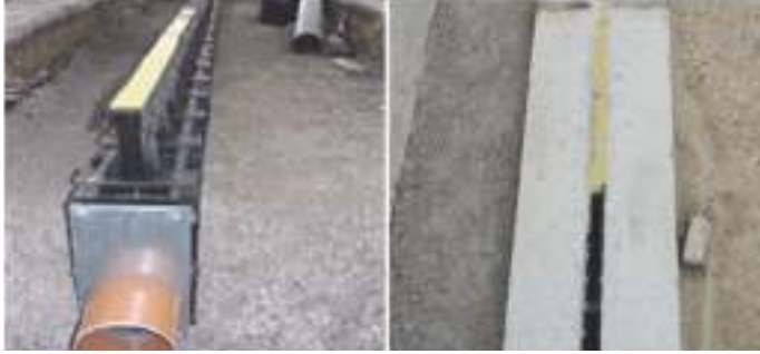
ŞEKİL 26 – TAŞMA KANALLARIN YERLEŞTİRİLMESİ
