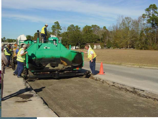
Yapım Sırasında Asfalt Serici Kullanılmış
